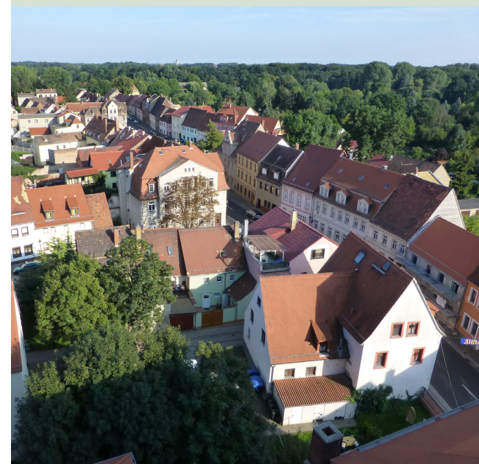
ECOVAST Exkursion nach Pegau, eine Kleinstadt in Sachsen, mit Blick vom Rathausurm über die Dächer der Stadt (Foto: Henckel 2015)
