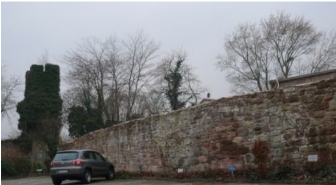
Abb. 1: Blick auf die Stadtmauer vor Bau des Seniorenheimes.
