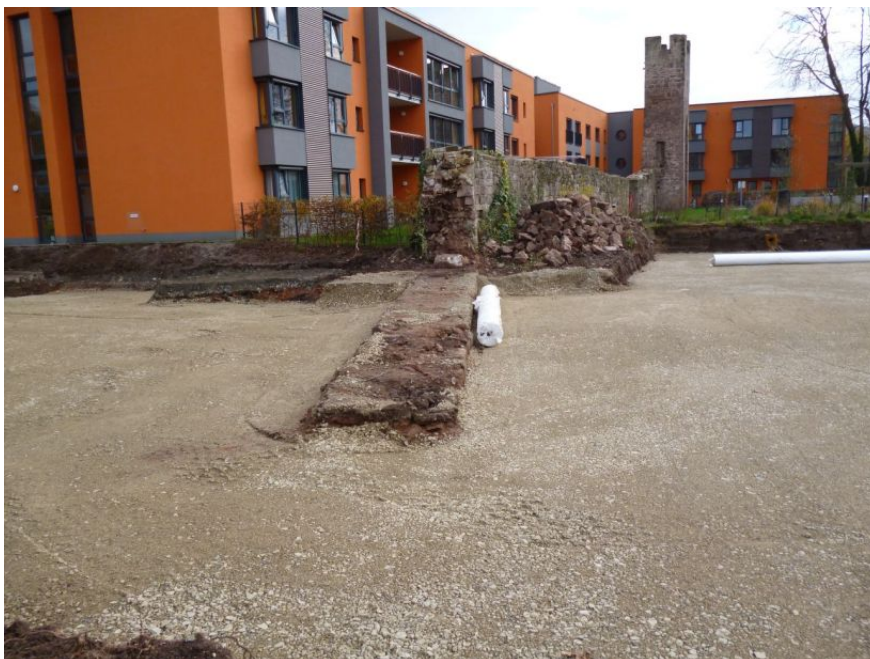
Abb. 3: Der bis auf einen Sockel abgetragene Abschnitt der Stadtmauer, der in die geplante Wohnanlage integriert werden soll.
